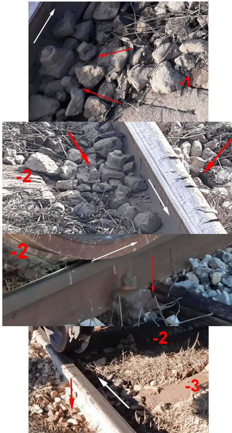
Слика 4.2.1.20: Стање причврсног прибора у зони првог упадања точка
