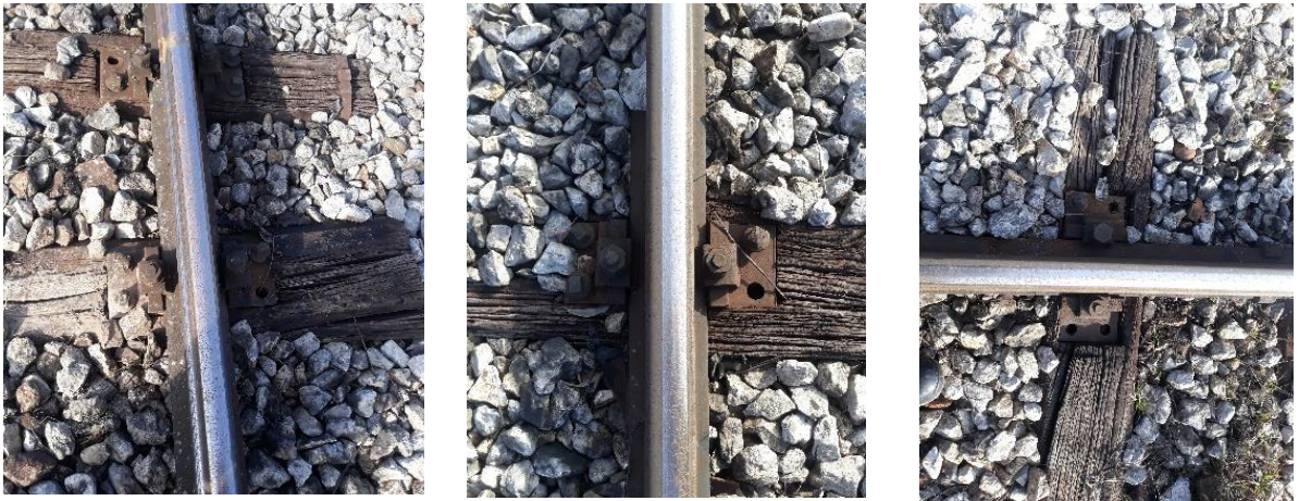
Слика 4.2.9.5: Изглед веза шина праг подложном плочом
