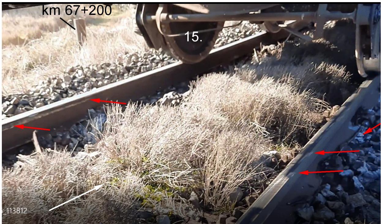
Слика 4.2.1.17: Траг исклизнућа на десној шини
