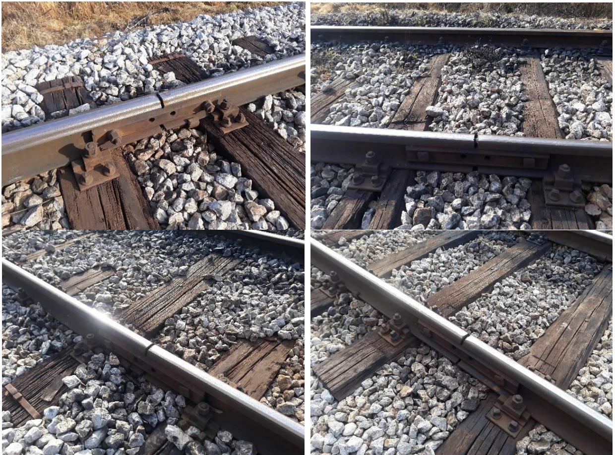
Слика 4.2.9.6: Изглед шинских састава (лебдећи ненаспрамни састави) у широј зони озбиљне несреће
