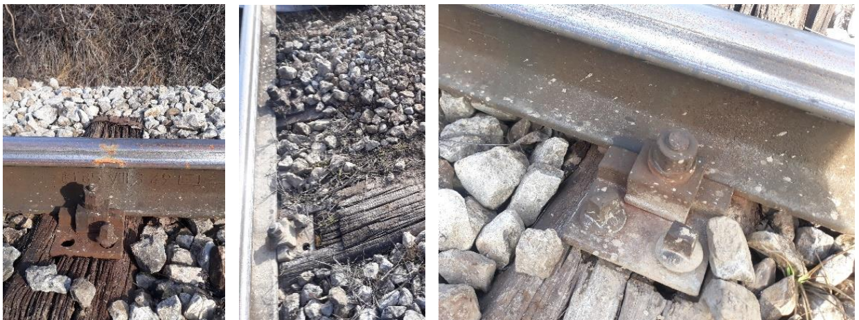
Слика 4.2.9.4: Изглед веза шина праг подложном плочом
